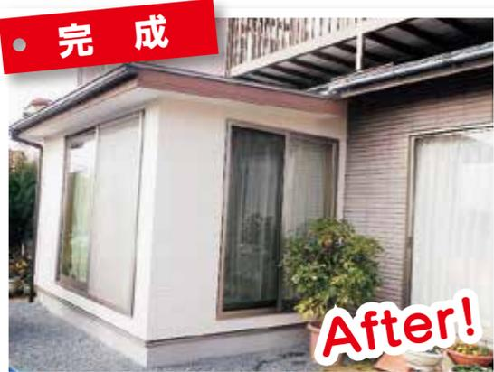
リビングから続く部屋を広げたいとの事で増築をしました。窓サッシは高断熱仕様にし、床・壁・天井には断熱材を入れ、冬でも暖かく過ごせる空間となりました。屋根は天井高を取る為、ガルバリウム鋼板仕上げに。
