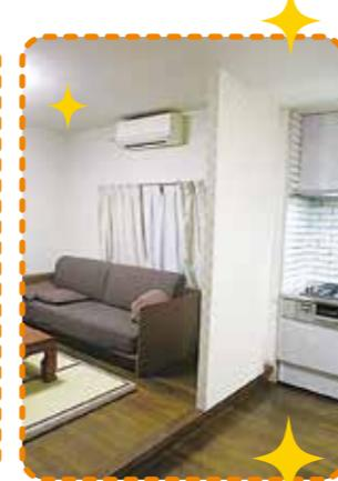
システムキッチンの老朽化や使い勝手の悪さを解消するため、入替をしました。全て引出しタイプとなり、収納力もアップし、取り出しやすくなりました。吊り戸は少し下げて施工し、手が届きやすいようにしました。間仕切壁を新設し、下地を入れ、将来、ご自身でラックや棚等取付が出来るようになりました。
