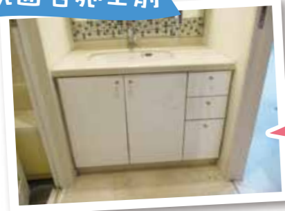
洗面台施工前
