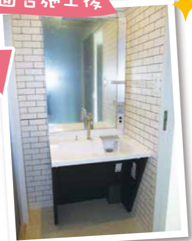
洗面台施工後
