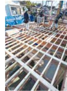
これは上棟時の写真で、2階の床を支える「根太」が入り2階の柱や梁が運び込まれている最中です！
