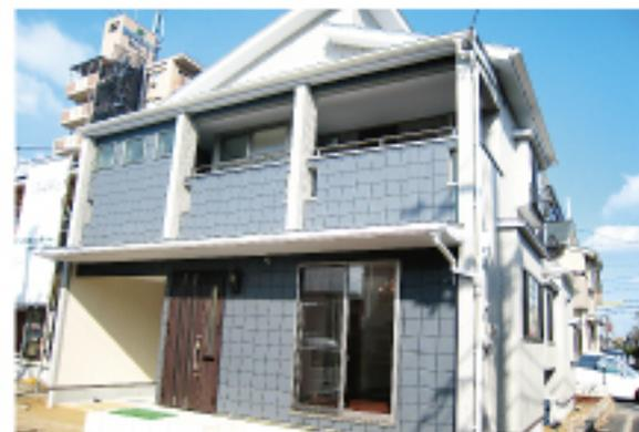
外観は凹凸によってデザインすることを心がけました。飽きの来ないシンプルな色彩を基本に使い、石目外壁の凹凸と庇でアクセントをつけ、単調なタイルの外観を引き締めています。屋根の形は当たり前の切妻を棟違いにすることによって、スマートな印象になるだけでなく、小屋裏収納の採光と通風を確保しています。
