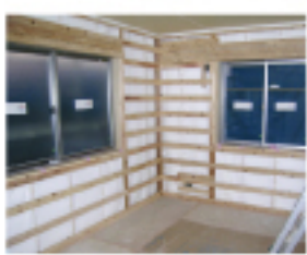
▲次世代断熱材のパーフェクトパリアの施工の様子
