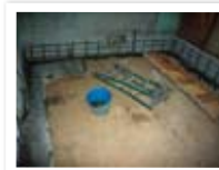
基礎鉄筋コンクリート 新設及び増打ち
