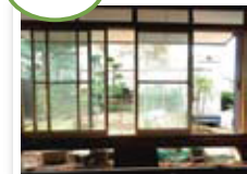
1F 和室(B) 和室+縁側を洋室に改装
