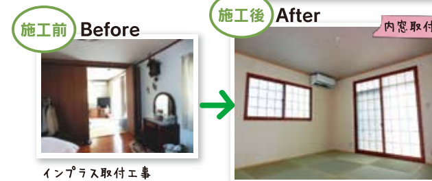
インプラス取付工事
