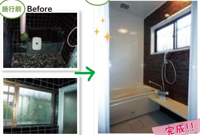
在来タイル張の浴室だった為、脱衣室との間に段差がありました。保温性・清掃性に優れているユニットバスにリフォームし、段差も解消されました。既設窓アタッチメントを使用する事で、既存の窓をそのまま利用してユニットバスに改装!!
