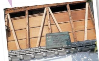
外壁を撤去 土壁を落として筋かい+金物で補強
