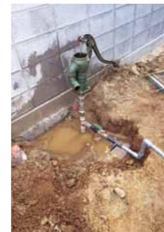
松山市北条で建築中のH様邸無添加住宅。先日、打ち抜き工事を行いました。掘る前は、水質、水量が不安でしたが、約7m掘った所で十分な水量を得る事ができ、一安心でした。年中、水温の安定した地下水、皆様も掘ってみませんか。
