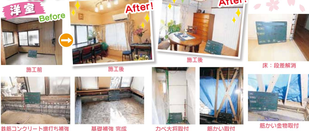
耐震改修補助事業を受けて耐震工事を行いました。基礎は鉄筋コンクリートで増打ち補強し、壁は筋かい+金物・カベ大将で補強しました。耐震改修工事に伴い洋室・和室を改装しました。プリント合板の壁からオレンジ系のクロス貼になり お部屋の中がスッキリとし暖かみのある空間になりました。出窓にはご家族で長年使われた思い出いっぱいの食卓テーブルを加工して再利用し取付け、カフェカウンターのような雰囲気仕上がりしました。
