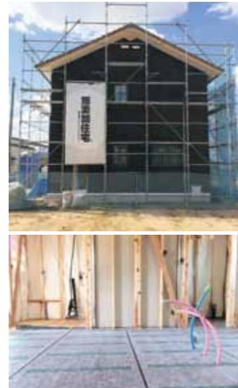
東温市で建築中のS様邸。現在、外壁に炭化コルクを施行中です。炭化コルクには優れた防音性と吸収性があります(1,000~2,000Hzの音を吸収)。また、衝撃吸収性により、音の振動を遮ります。これにより、従来の構断熱・高気密住宅の「音が響く」という弱点を解消します。さらに、2世帯住宅のS様邸は内部にも遮音工事を施しています。2階床の衝撃音を遮断するための「遮音シート」、振動を伝えにくくする「防振吊木」。木造住宅の音が響きやすいというデメリットを軽減するためのものです。より快適な室内空間をつくるために、無添加住宅は進化していきます。
