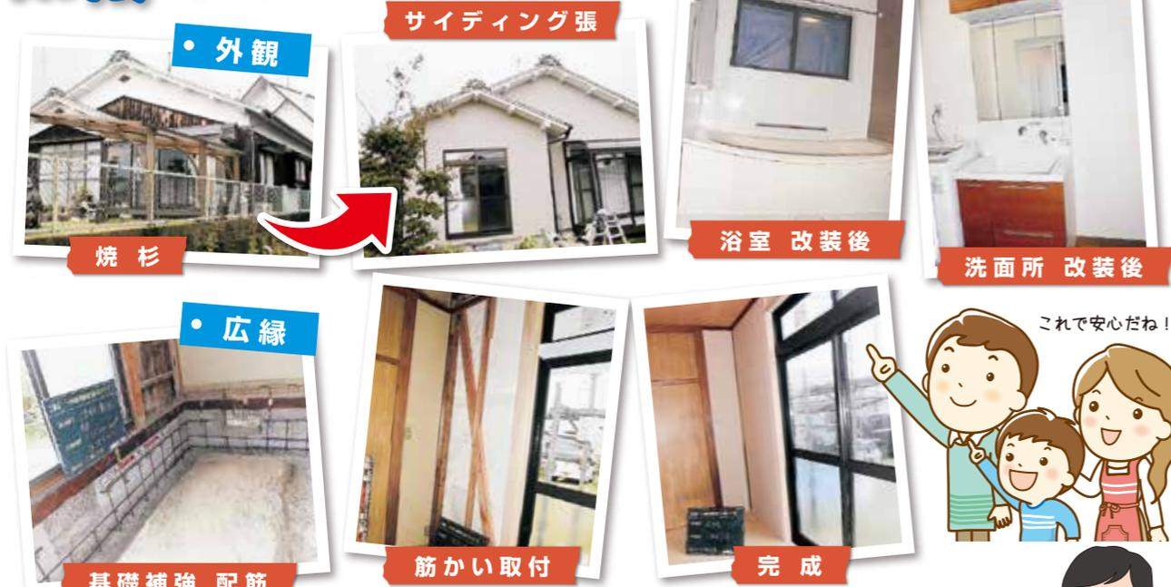
耐震改修と合わせて、外壁焼杉板張をサイディングに張替えました。広縁の基礎補強と、筋かい取付により安心して快適に暮らせるようになりました。
