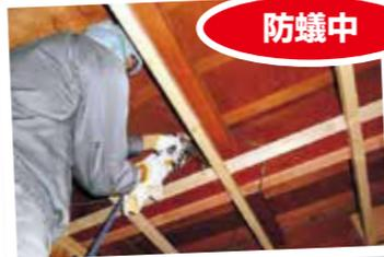
地面から柱を通り、キッチン天井と柱に白蟻の被害がありました。キッチンの柱と、桁には白蟻の蟻道もはっきりとわかります。柱を入替え、内部が空洞になっていた桁は、両側から新設の桁で挟み補強しました。
