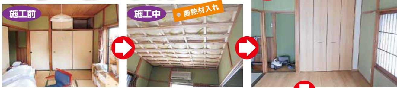
和室の畳を撤去しフローアーに貼り替え、押入は解体しクローゼットに取替えました。また、壁は既存のまま活かし、天井はビニールクロスに貼り替えました。今回の和室は2階でしたので天井を解体し、小屋裏に断熱材(グラスウール100ミリ)を施工しました。夏・冬も快適に過ごしていただけたらと思います。
